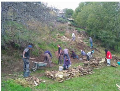
18 novembre 2019 – 1 er jour du chantier
